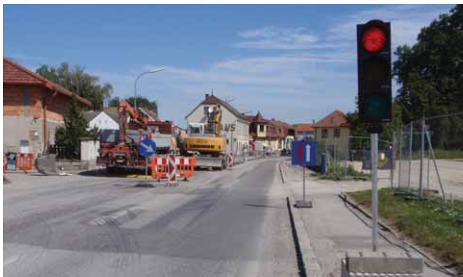
Mit enormem Aufwand war die Sanierung des Eggendorfer Kanals verbunden.
