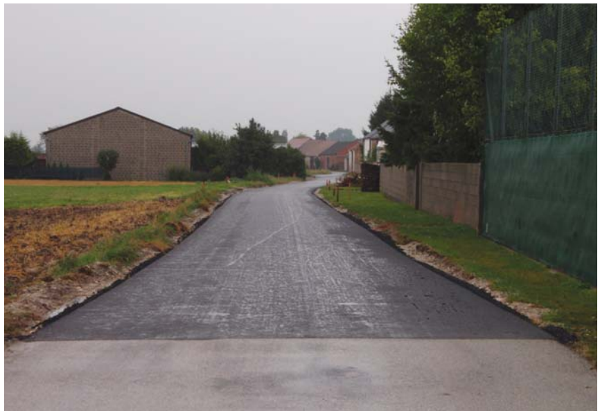
Die Obere Feldgasse kurz nach Beendigung der Sanierungsarbeiten.
