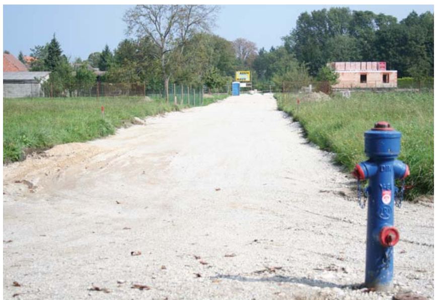
Die neu errichtete Baustraße für die Erschließung der Hofgartengasse.
