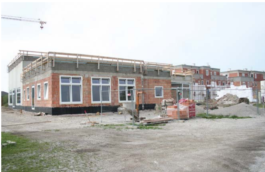
Die Bauarbeiten auf der Vorbehaltsfläche machen weiterhin sichtbare Fortschritte. Die Wohnungen der Siedlungsgenossenschaft Neunkirchen und auch das Gemeindezentrum der Siedlung Maria Theresia nehmen deutlich Gestalt an.
