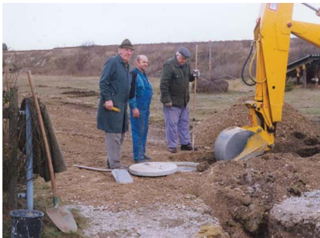
Friedrich Oberhauser, Hugo Lampel und Stefan Toth bei der Verlegung der Wasserleitung.
